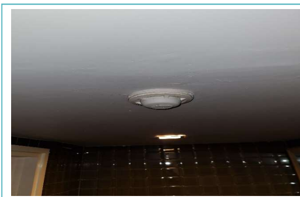
รูปภาพที่ 1.52 อุปกรณ์ระบบสัญญาณเตือนภัย อุปกรณ์ตรวจจับความร้อน (Heat Detector) และ อุปกรณ์แจ้งเหตุเพลิงไหม้แบบเสียง (Fire Alarm Speaker)
